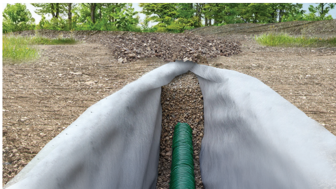
05 SCHEMA Corretta realizzazione del sistema di drenaggio
