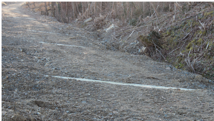
04 FIGURA Drenaggio mediante canalette di deflusso verso un impluvio naturale
