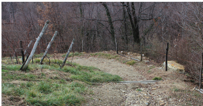
03 FIGURA Area di manovra con drenaggio sistemato
